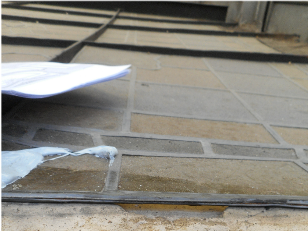
CUADRANTE 7, PIEZA 12A. Silicona en reparaciones puntuales y encuentro irregular con cornisa.
