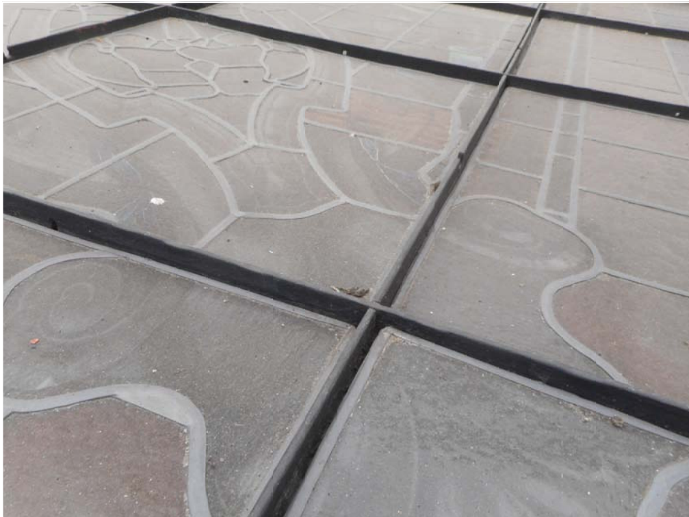
CUADRANTE 7, PIEZA 11B. Deformaciones en placas
